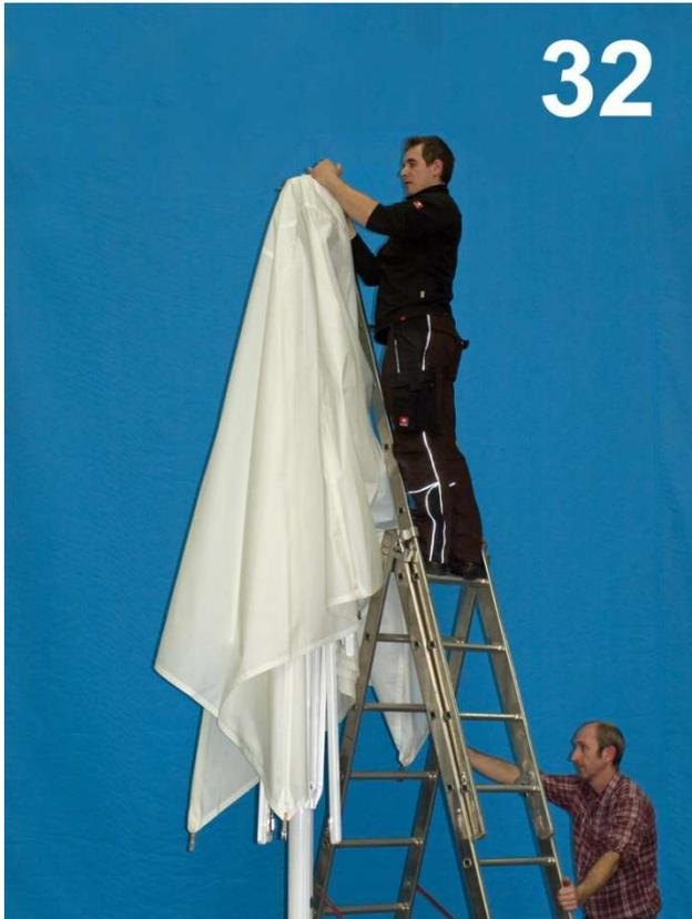
Sobald die Membrane vollständig abgelassen ist, **finden Sie** – speziell bei quadratischen Schirmen [wie bei dieser Demonstration] - **denjenigen oberen Membranhaken heraus, von dem aus eine lange Diagonalnaht durch die Membrane nach unten/außen verläuft. Diesen Haken klinken Sie als allerersten (!) oben in die offene Kammer des Diagonalspeichenprofils ein.**
