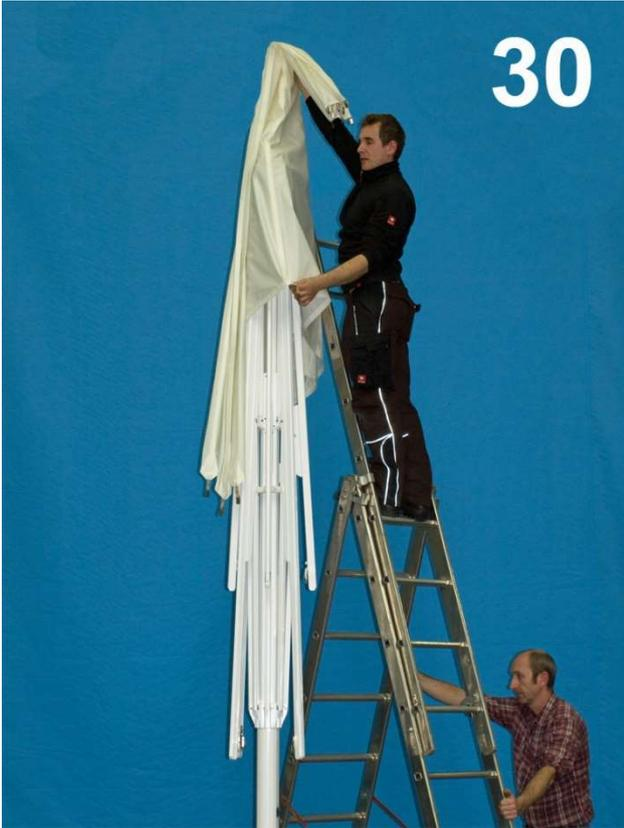
**Während Sie das Kopfteil der Membrane mit Ihrem rechten Arm hochhalten [um zu vermeiden, dass das Gewebe durch unbeabsichtigten Kontakt mit den Metallteilen des Gestellkopfes beschädigt wird], lassen Sie die Membrane Schritt für Schritt...**
